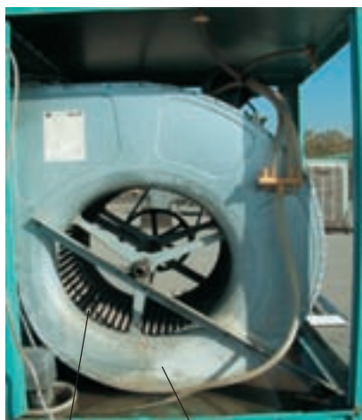
شکل ۸-۹ - محرک گردان کلید گریز از مرکز
