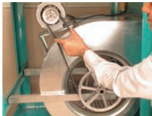
الف- طرز قرار گرفتن تسمه روی پولی‌ها
