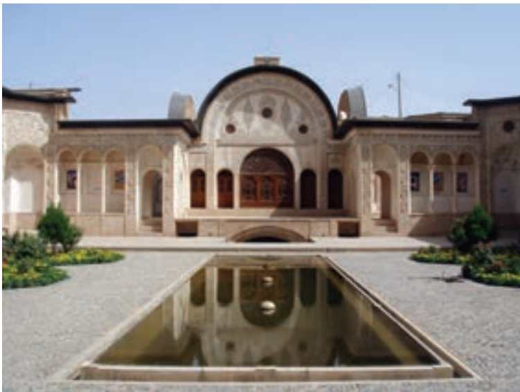
شکل ۲۶-۴ خانه طباطبایی‌ها در کاشان (قوس نیم دایره)
