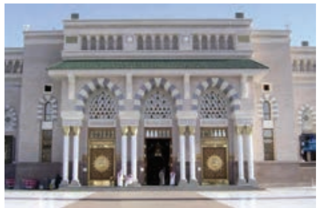
▲ شکل ۴-۷۰ قوس های سنگی (مسجد پیامبر)
