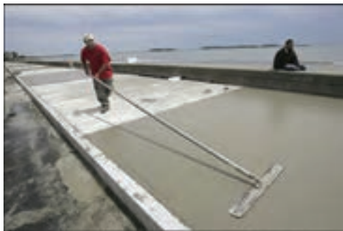
▲ شکل ۳-۵۵ رویه نهایی معابر با بتن درجا
