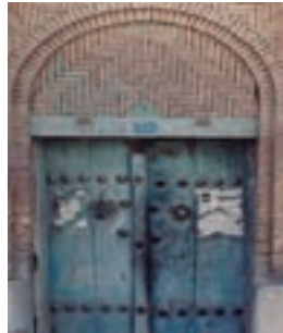
▲ شکل ۴-۷ کاربرد قوس در نعل درگاه
